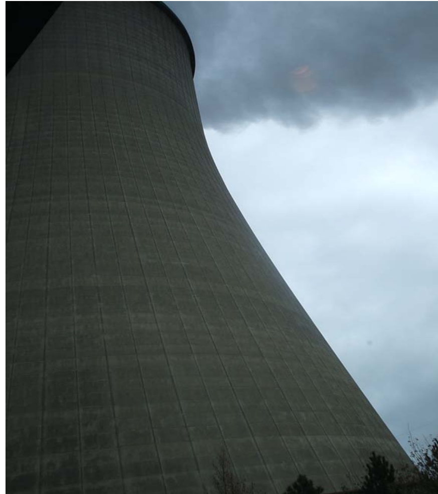
Kühlturm des RWE Kraftwerkes Ibbenbüren
